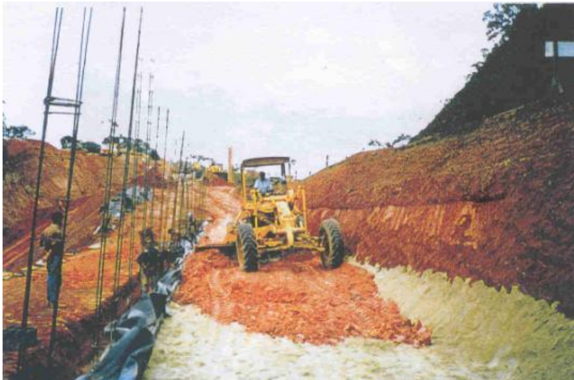
Foto 1 - Camada de solo reforçado sendo executada.
