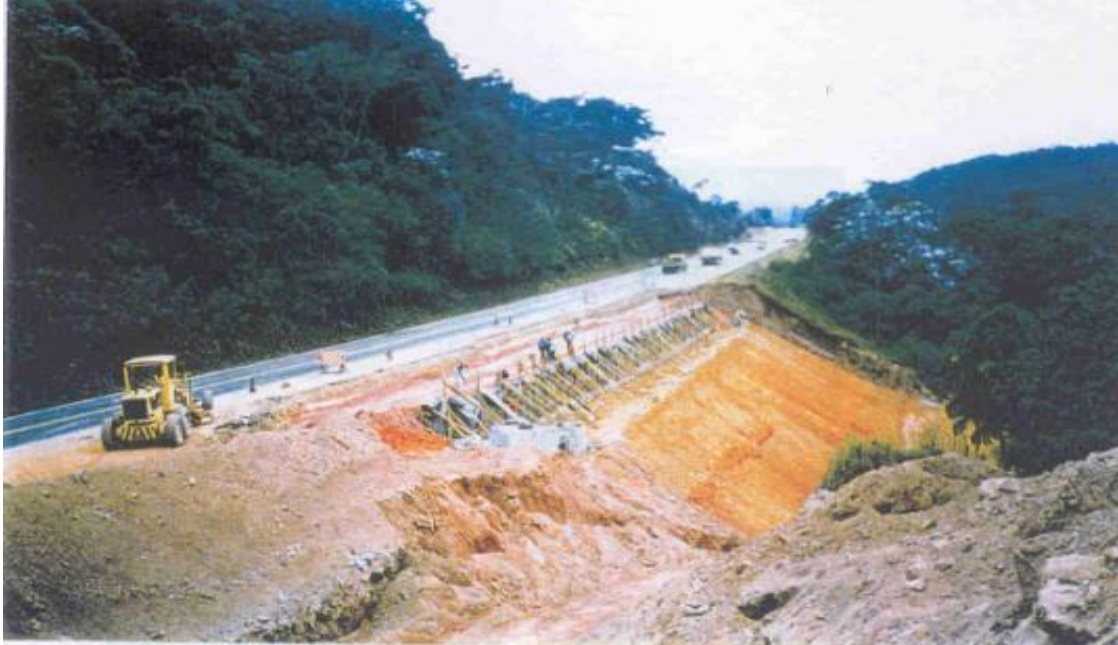
Foto 2 - Vista geral superior da obra - Vista do colchão drenante de areia ao fundo.
