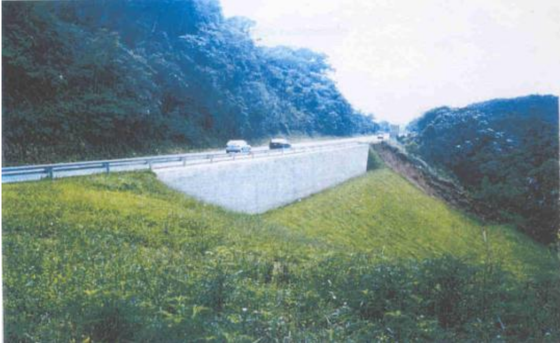
Foto 4 – Obra acabada e a proteção com alvenaria.
