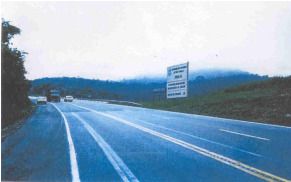
Foto 5 - Vista do pavimento recuperado.
