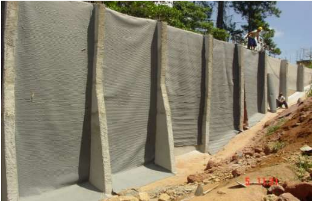
Foto2: Drenagens verticais, conhecido como cortinas drenantes.
