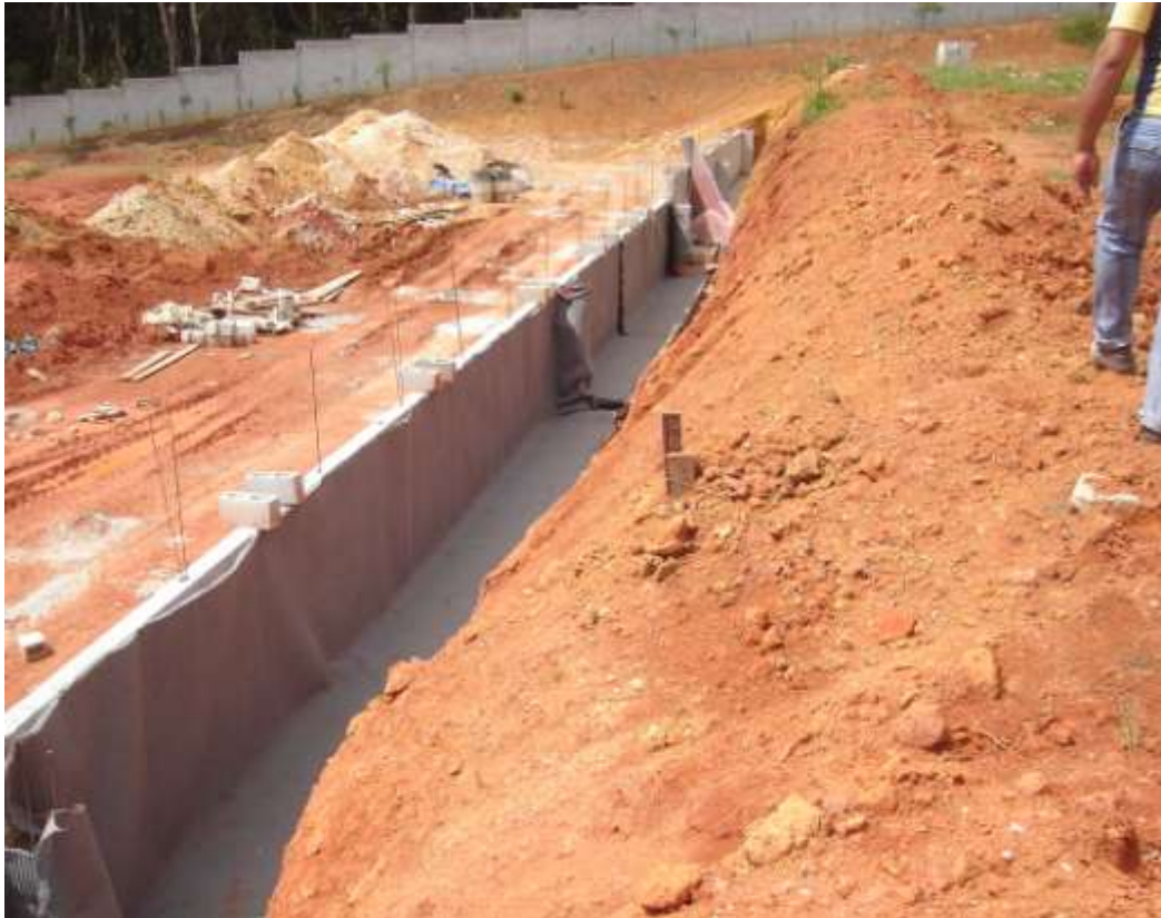
Foto 4: Aplicação do MaxDren 320R em drenagem de murros de arrimo.
