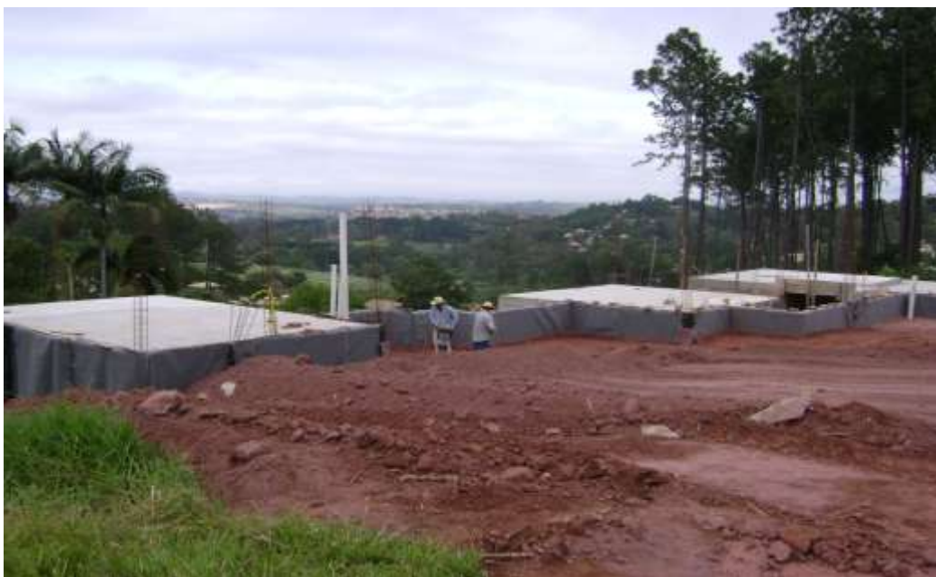
Foto 3: MaxDren 320R já aterrado. Ele foi aplicado em todo o contorno da construção.
