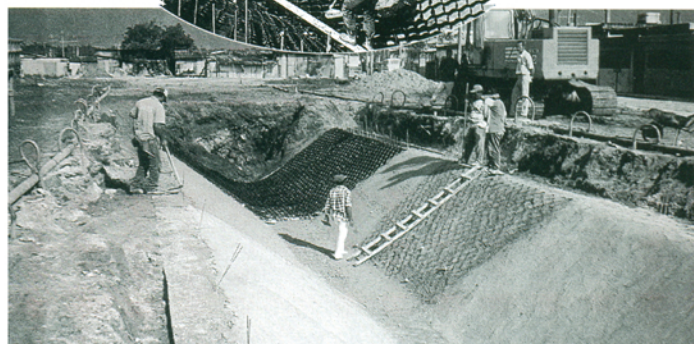
Vista da instalação de GEOWEB. No detalhe, facilidade de preenchimento das células com concreto
