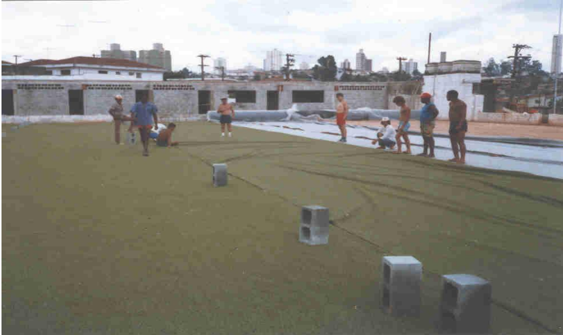
Foto 3 - Ajuste da grama artificial sobre o Geotêxtil Bidim .
