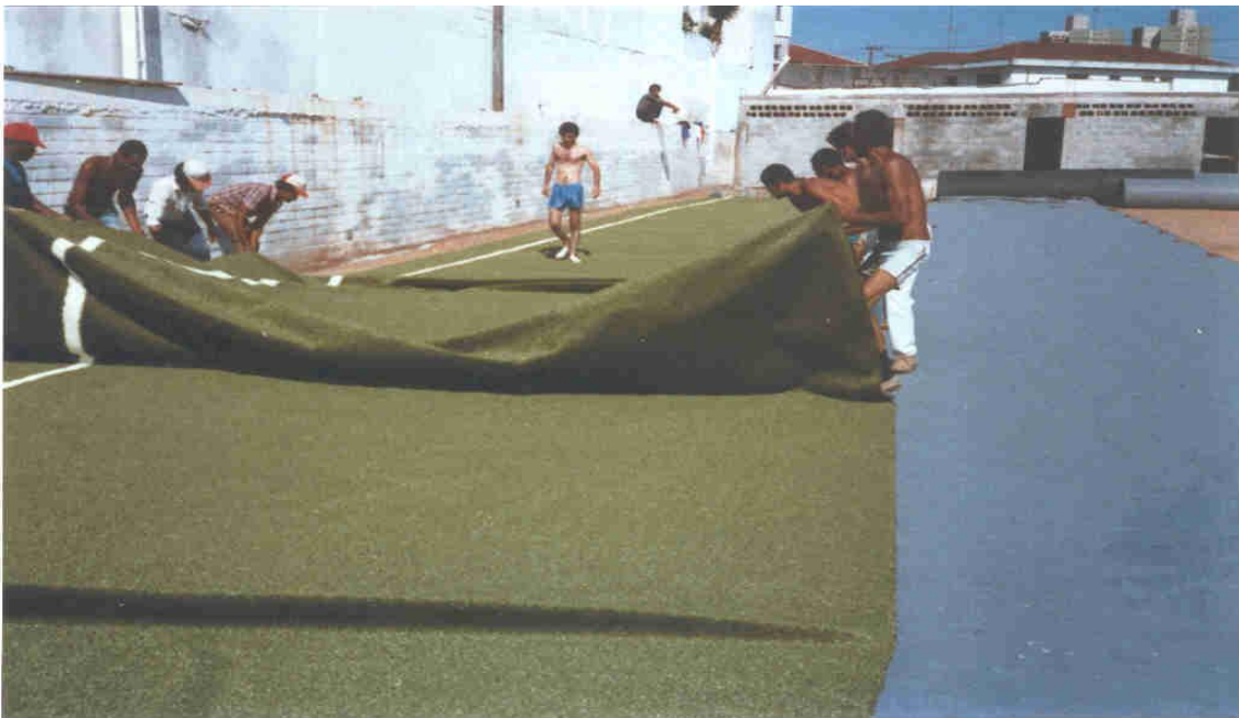
Foto 2 – Colocação da grama artificial sobre o Geotêxtil Bidim .
