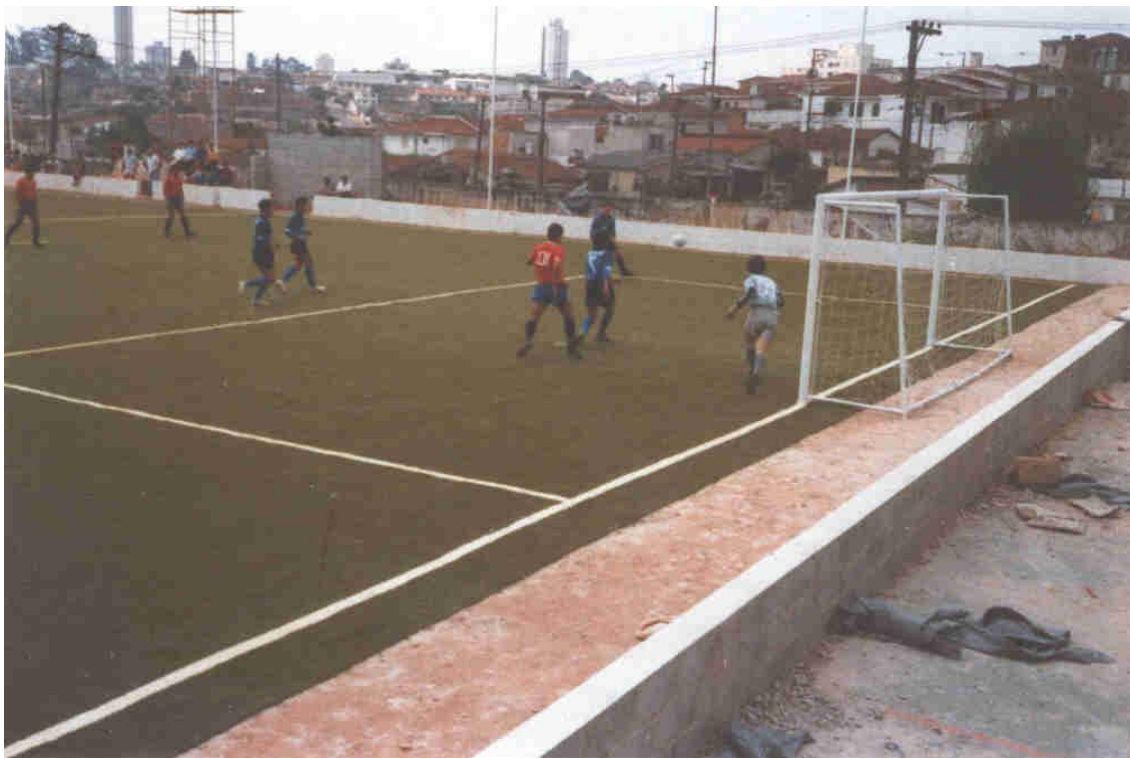
Foto 5 – Detalhe do Campo após da obra.
