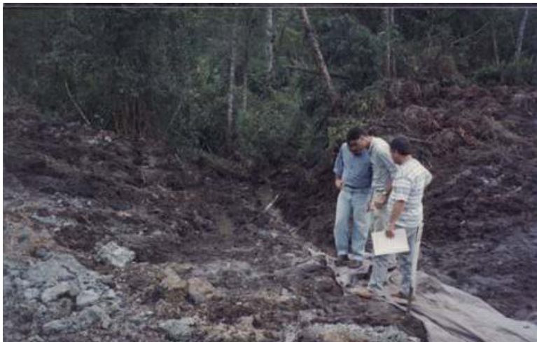
Detalhe da saída lateral da trincheira drenante.
