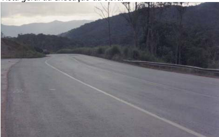
Trecho de obra concluído.
