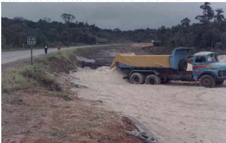
Espalhamento do material de aterro sobre o Bidim.
