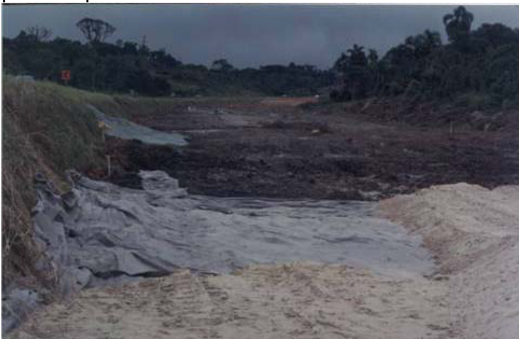
Vista geral da execução da obra.
